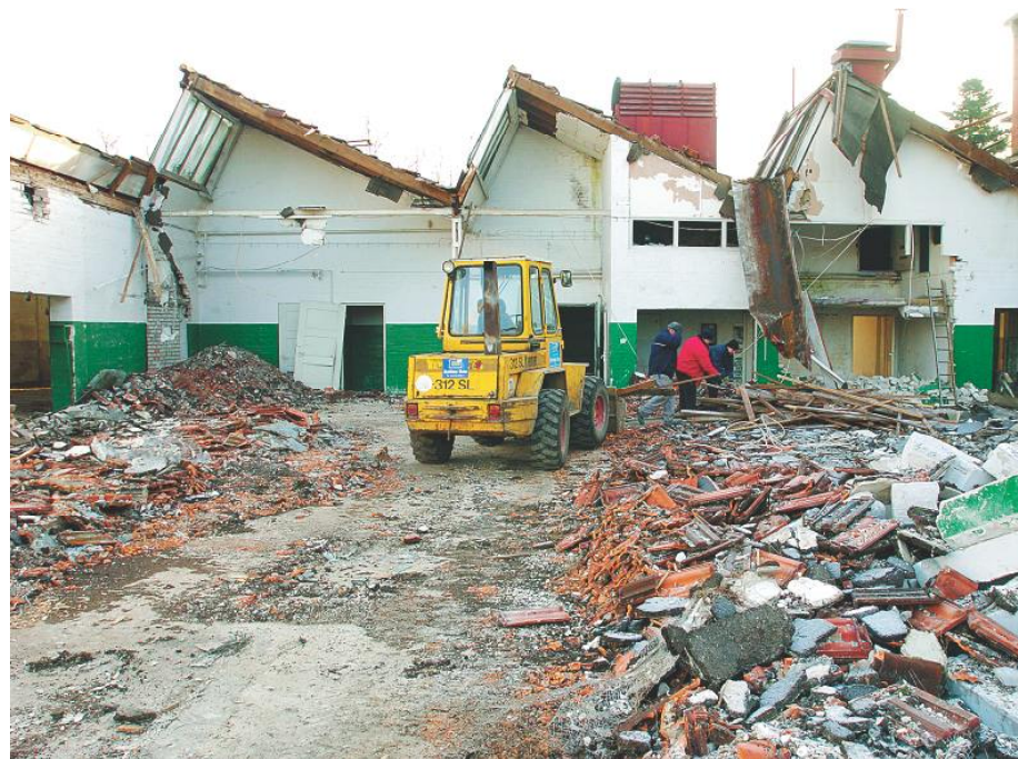
Vor vier Jahren wurde die Bürstenfabrik abgerissen.
